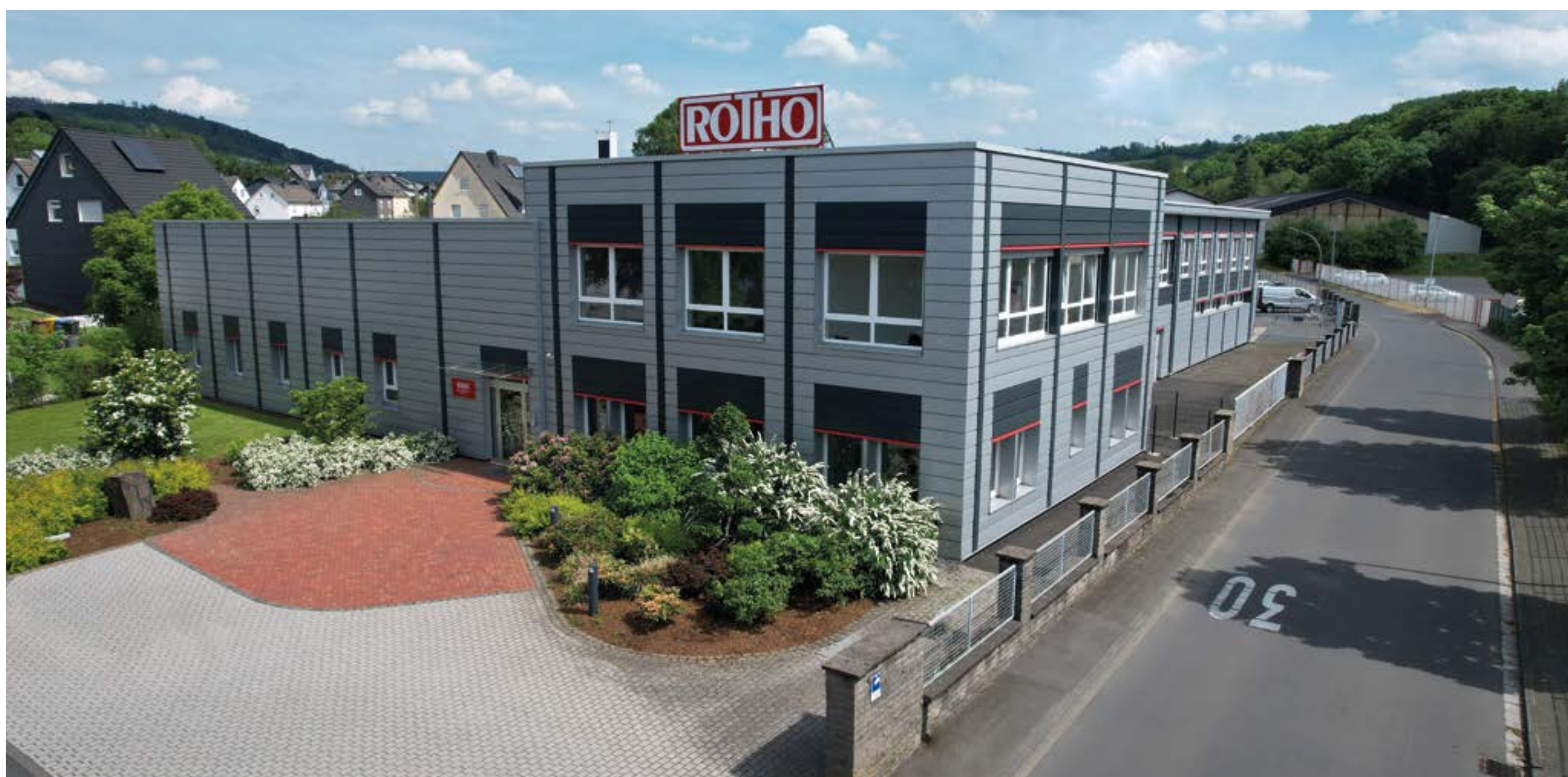
Siège social de ROTHO, Neunkirchen, ALLEMAGNE
